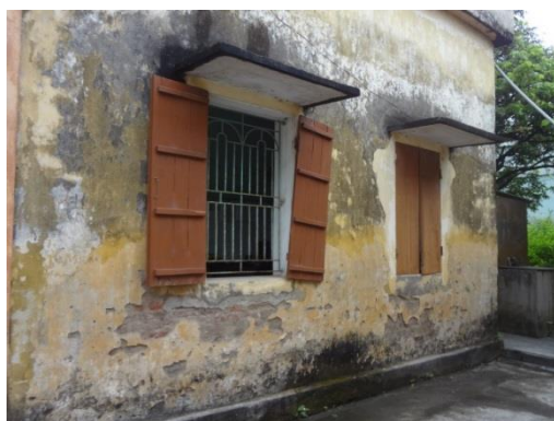
Khu nhà cũ đã xuống cấp
