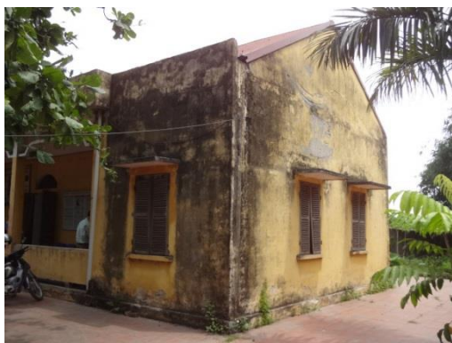
Khu nhà cũ đã xuống cấp
