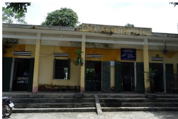
Trạm y tế hiện tại
