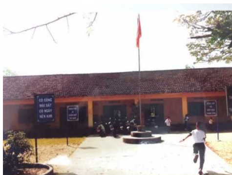
Tòa nhà hiện tại của trường (xây năm 1989)
