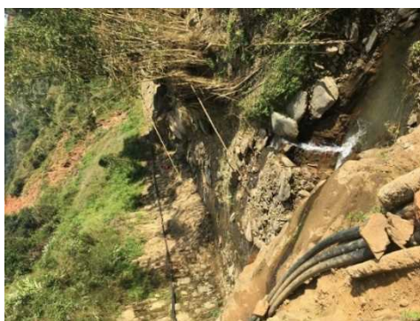
Đường ống dẫn nước trần trên đất đá (phía bên phải)
