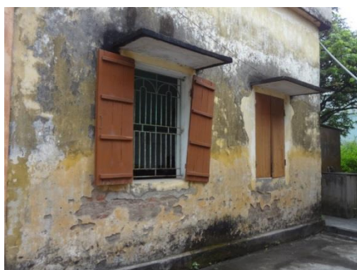
老朽化した診療棟外観
