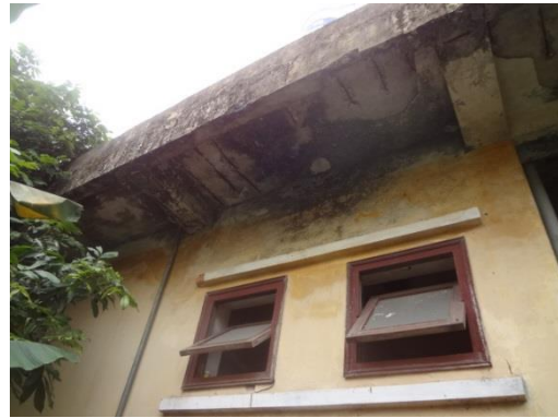
Phần mái thấm dột
