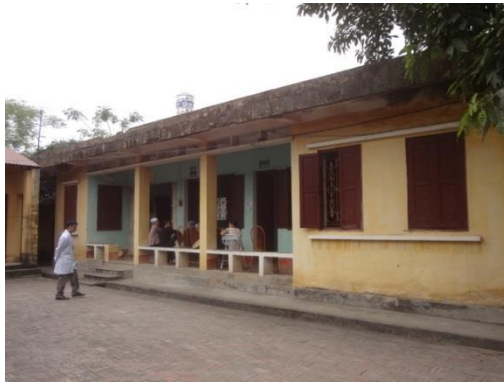
Khu nhà cũ sẽ phá dỡ
