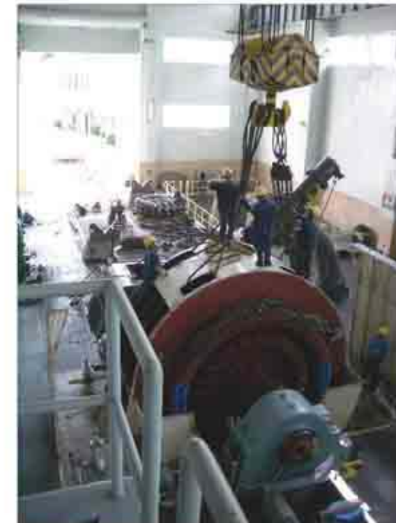
↑ Công tác bảo dưỡng Nhà máy Thủy điện Đa Nhim.
