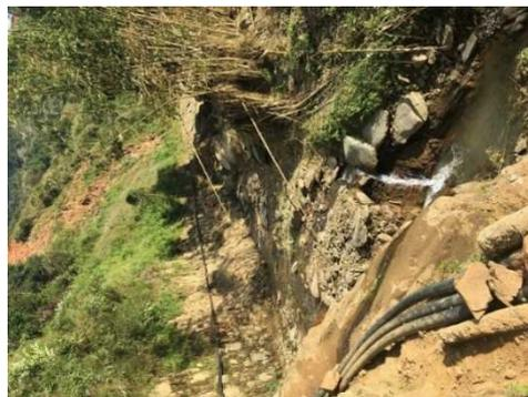
土砂によってパイプが剥き出しとなっている（右側手前）
