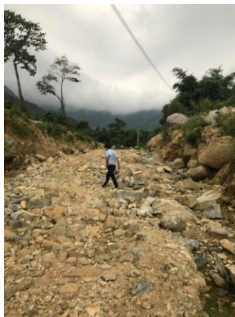
Một phần con đường được đắp bằng đất đá
