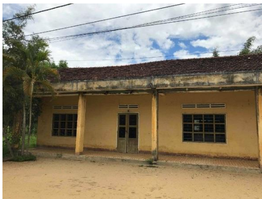
現在は使用されていない校舎
