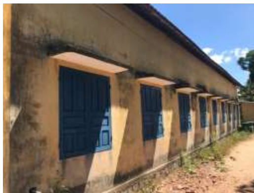
劣化が進む校舎
