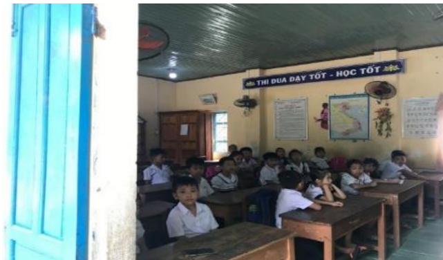
教室の様子（扉が老朽化している）
