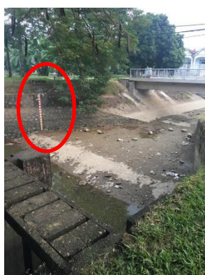
ポンプ場の放水口の水位計
