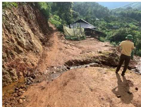
大きな溝ができていない道路の始まり
