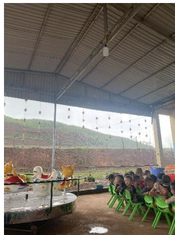
水漏れする園舎
