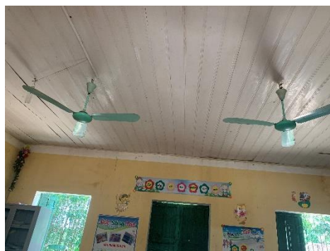
劣化した天井とカビの生えた壁
