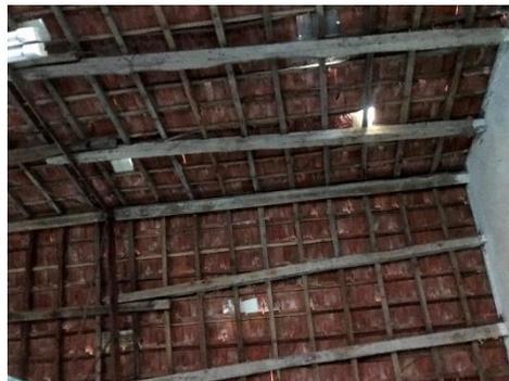
現在の教室の天井を支えている梁の損傷も激しい
