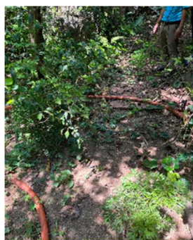
公衆トイレ用の浄化槽（CE25）の設置予定地
