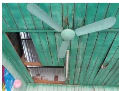
穴の開いた天井
