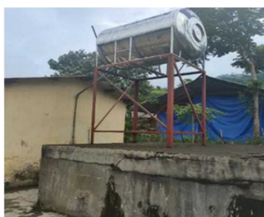
コックファット村小学校給水タンク
