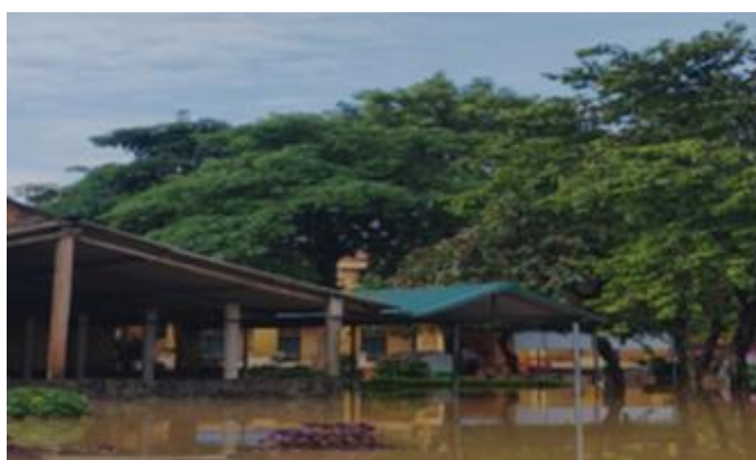
台風3号（ヤギ）により被災した小学校
