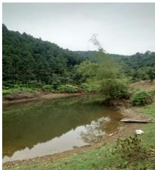
Đập bị sập bờ chắn do ảnh hưởng của cơn bão số 3 (Yagi)
