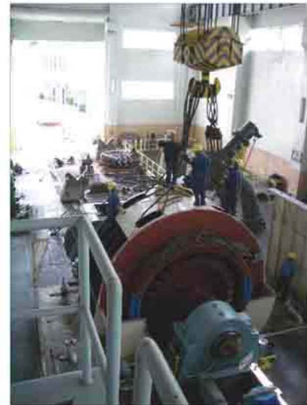
↑ ダム発電所のメンテナンス作業
